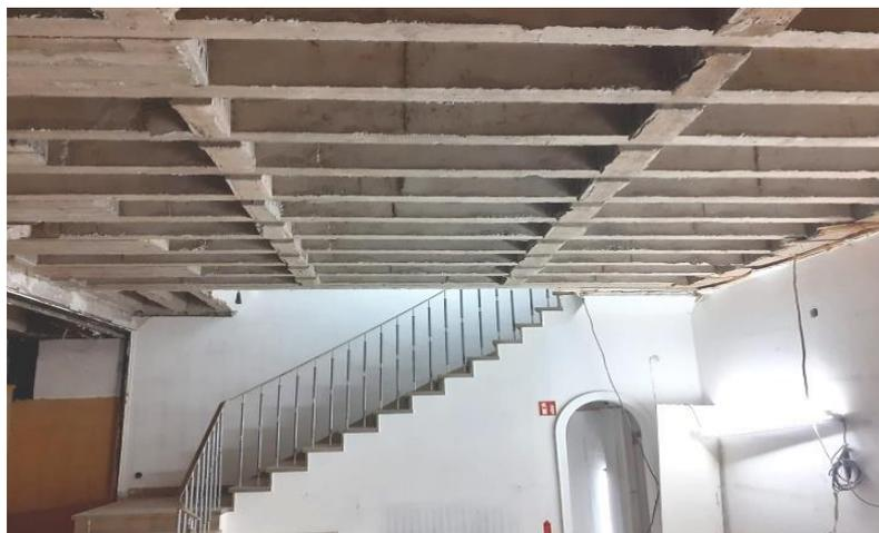
Durchführung von Probebohrungen, kompletter Rückbau der Deckenunterkonstruktion und Wandkonstruktionen auf Rohbaustand.
